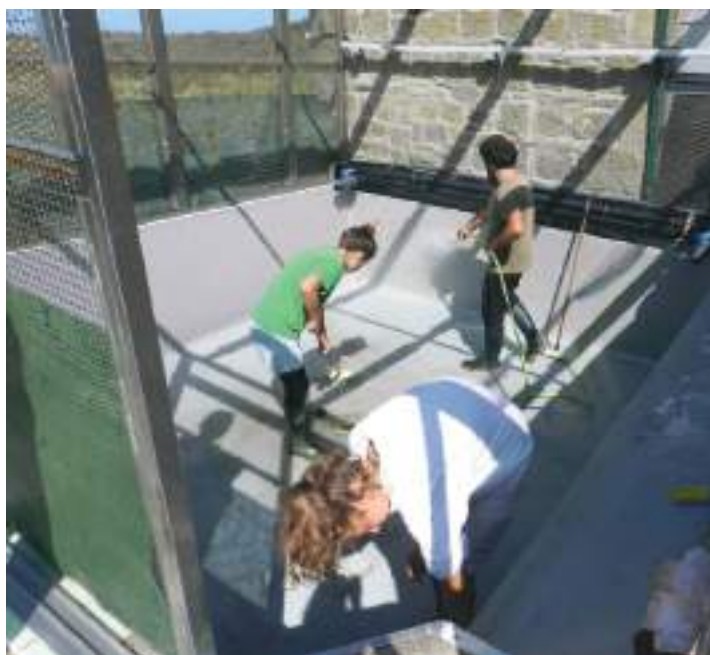
Nettoyage des piscines rénovées
