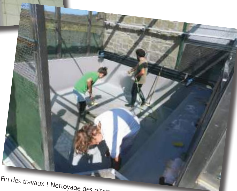
Rebouchage et préparation des supports avant mise en place du liner
