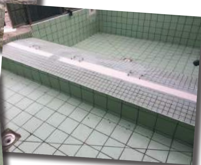
Rebouchage et préparation des supports avant mise en place du liner
