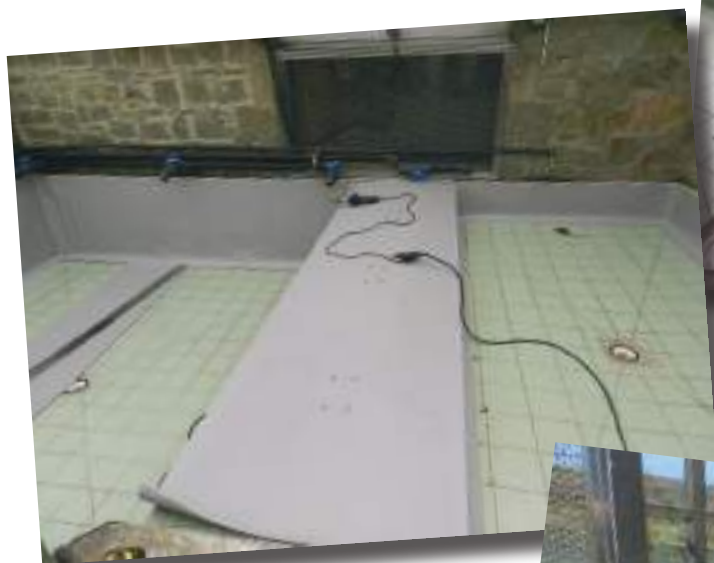
Mise en place du liner d'étanchéité
