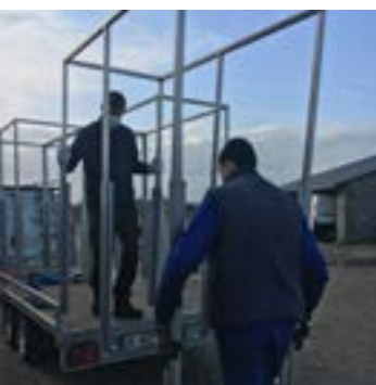
Déchargement des modules.
