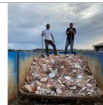
Après la démolition des cloisons de l'ancien centre de soins et l'évacuation des gravats à la brouette !
