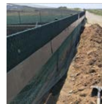
Le grillage galvanisé installé dans l'une des tranchées creusées autour de la grande volière.
