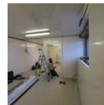
En seulement 2 jours, la pose des panneaux isothermes a bien avancé !
