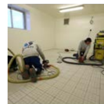
Après les murs, le sol. Avant de commencer la pose de la résine, l'ancien sol carrelé doit être poncé.
