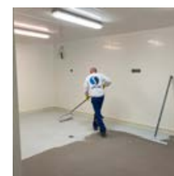
Application de la dernière couche de résine au sol
