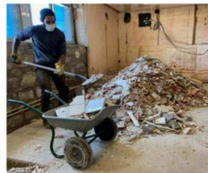
Les anciennes cloisons, présentant d'importants problèmes d'infiltration, ont été abattues. (LPO)
