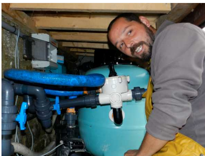
Réparation du système de filtration
